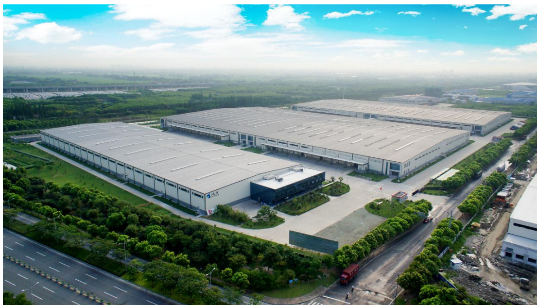
图 14-3 富莱德昆山物流园一期实景图
