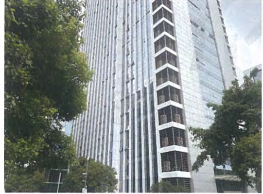
高新园拓展 D 区项目外观
