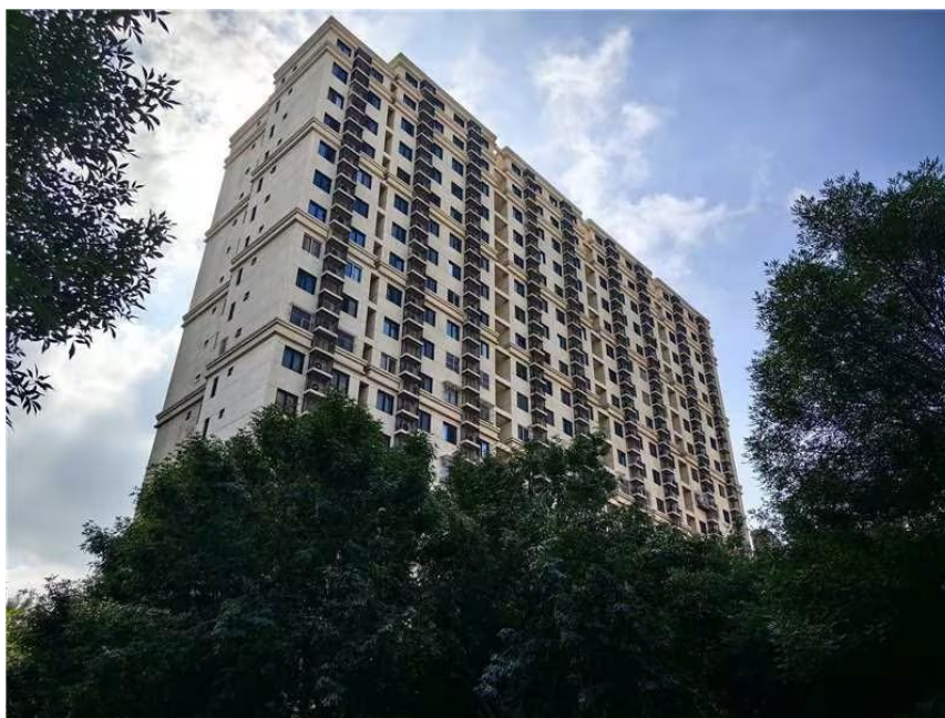
图 14-3 盛悦家园项目实景图
