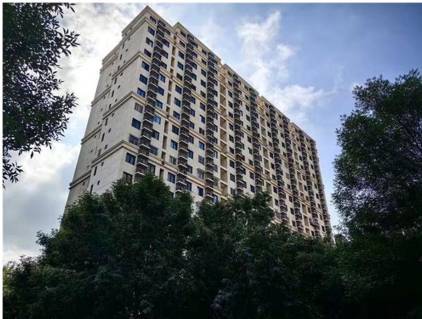
图：盛悦家园项目实景图
