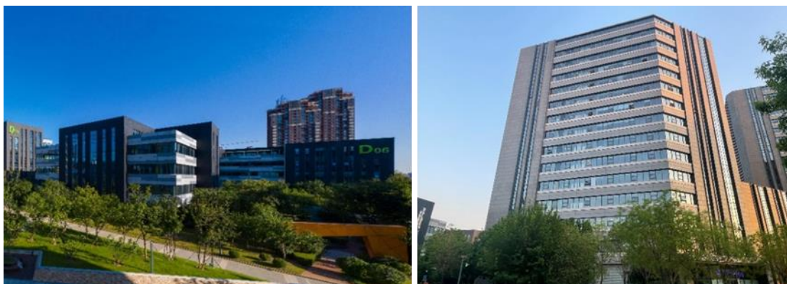
图 14-1-3: 软件园 D、E 区项目实景
