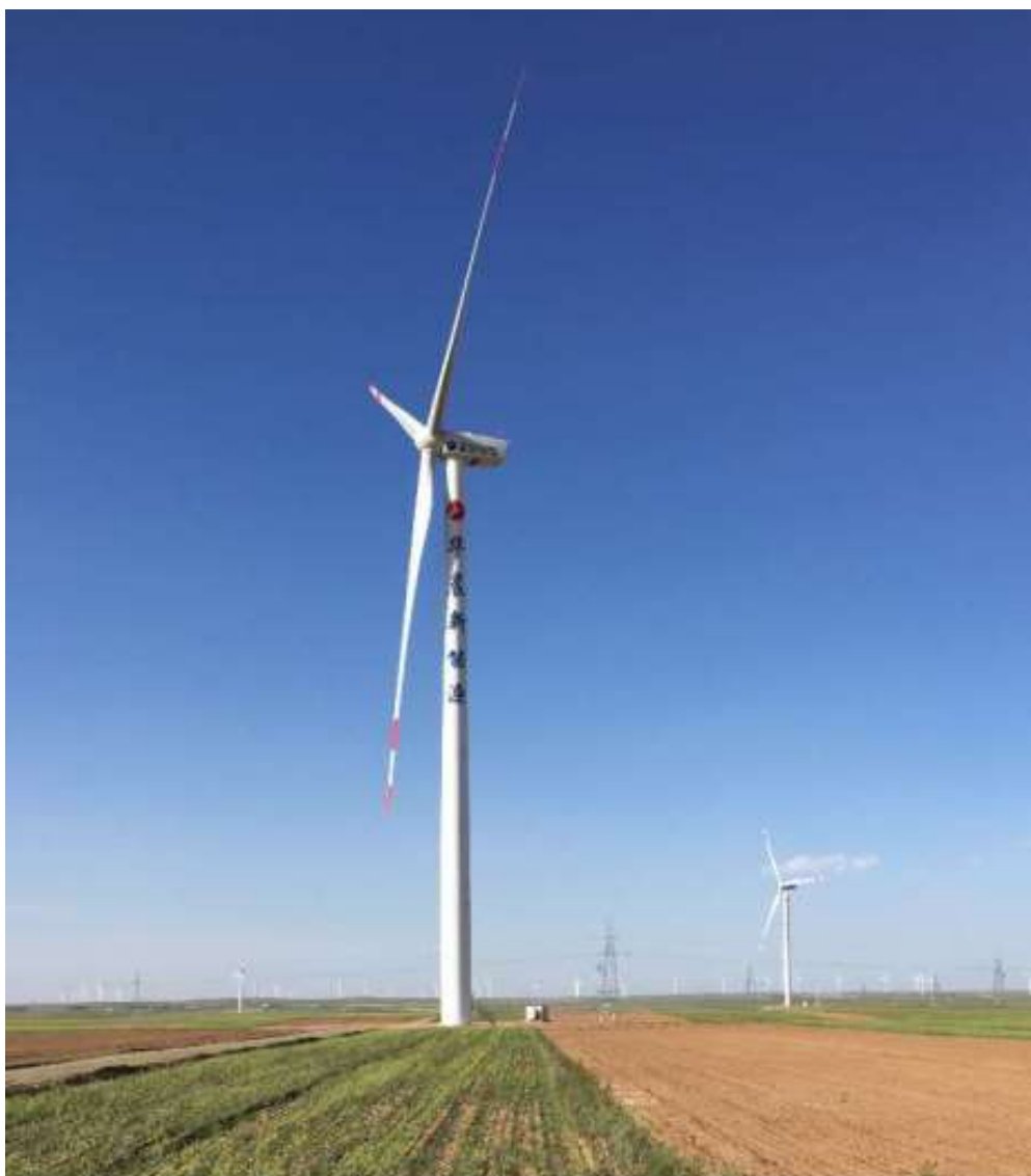
图 2-12：华晨风电项目现场图
