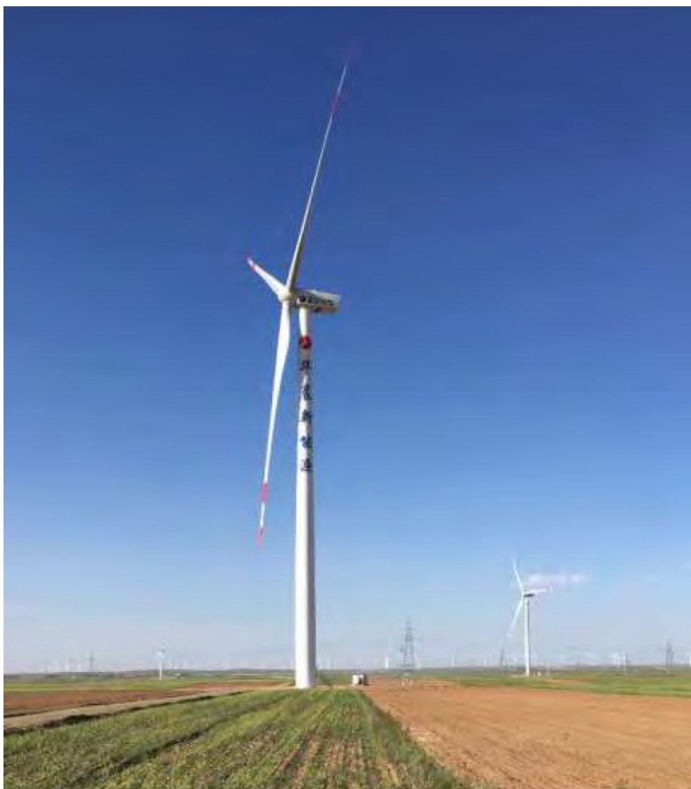
图 2-12：华晨风电项目现场图
