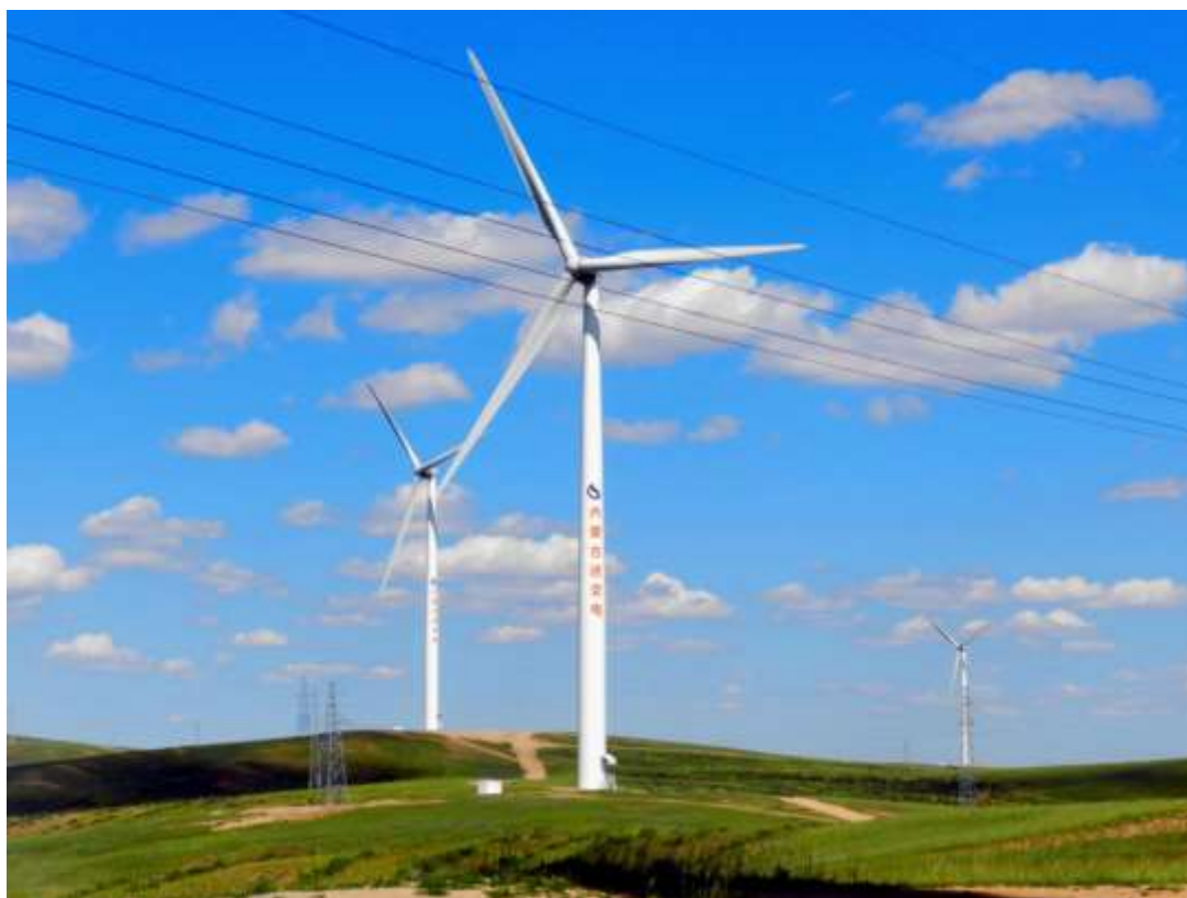
图 2-13：恒润一期风电项目现场图
