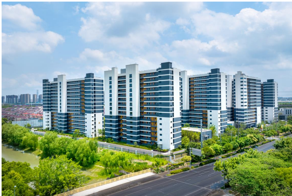
图 14-2 有巢马桥项目实景图
