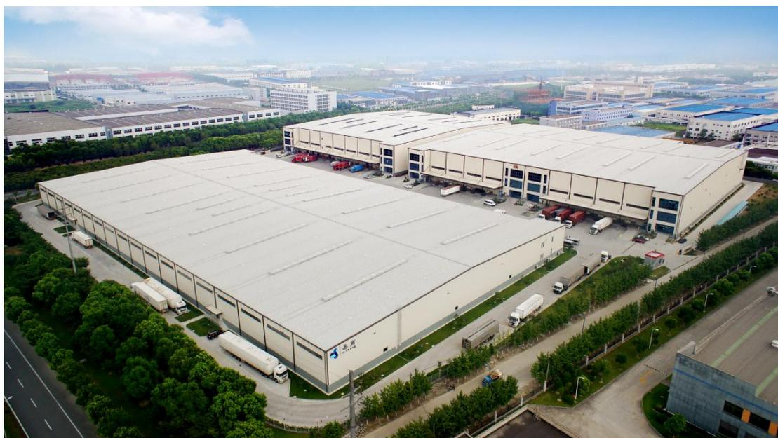
富莱德昆山物流园二期包括 1 幢单层仓库（仓库#A）、2 幢双层电梯式仓库（仓库#B-#C）、1 幢单层设备房、1 幢单层压纸机房和 2 幢单层门卫房，总建筑面积为 85,674.21 平方米，约于 2013 年建成。富莱德二期仓库#A 为轻钢结构，仓库#B 和仓库#C 为钢及钢筋混凝土混合结构，屋面为单层钢板，外墙板为单层钢板，同时采用墙面保温棉和内墙板，内部安保监视系统、消防烟感报警喷淋系统等配套设施齐全。仓库#A 为单层，净高约 9 米，仓库#B 和仓库#C 为双层，一层净高约 9 米，二层净高约 6 米；三幢仓库均配有高约 1.3 米的单边卸货平台；压纸机房为单层钢结构，设备房与门卫房均为单层砖混结构。
