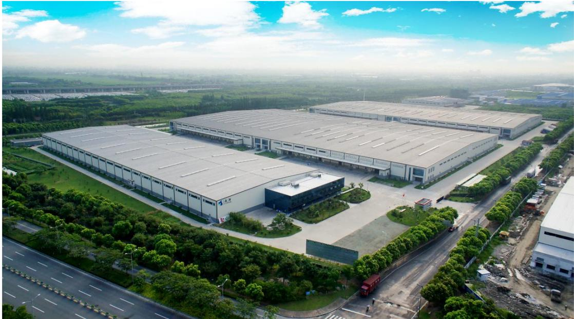
富莱德昆山物流园一期包括 4 幢单层仓库（仓库#A-#D，其中仓库#A 及仓库#D 局部有二层）、1 幢 2 层办公楼、1 幢单层设备房和 3 幢单层门卫房，总建筑面积为 135,080.85 平方米，于 2011 年建成。富莱德一期仓库为轻钢结构，屋面为单层钢板，外墙板为单层钢板，同时采用墙面保温棉和内墙板，内部安保监视系统、消防烟感报警喷淋系统等配套设施齐全。4 幢仓库均为单层，净高约 9 米；仓库#A 和仓库#D 配有高约 1.3 米的单边卸货平台，仓库#B 和仓库#C 配有高约 1.3 米的双边卸货平台；仓库#A 和仓库#D 局部 2 层作办公用途，办公区域采用塑料扣板吊顶，内墙刷涂料，地面铺设地砖；办公楼为 2 层，钢混结构，地面铺地砖，天花板吊顶；设备房与门卫房均为单层砖混结构。
