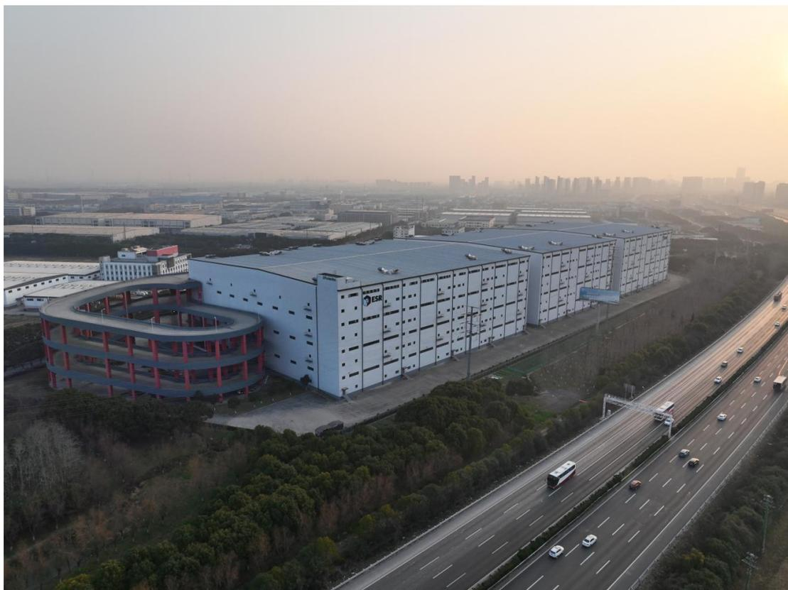
富莱德昆山物流园三期包括 3 幢四层坡道式仓库（仓库#A-#C）、1 幢单层设备房和 1 幢单层门卫房及辅助用房，总建筑面积为 206,417.87 平方米，约于 2018 年建成。富莱德三期仓库为钢及钢筋混凝土混合结构，屋面为单层钢板，外墙板为单层钢板，同时采用墙面保温棉和内墙板，内部安保监视系统、消防
