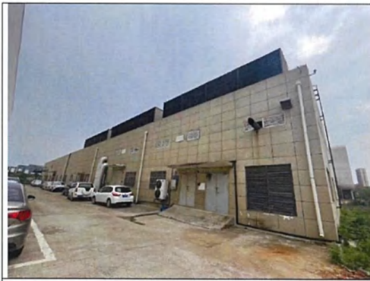
【保障动员中心配套楼】-建筑外观
