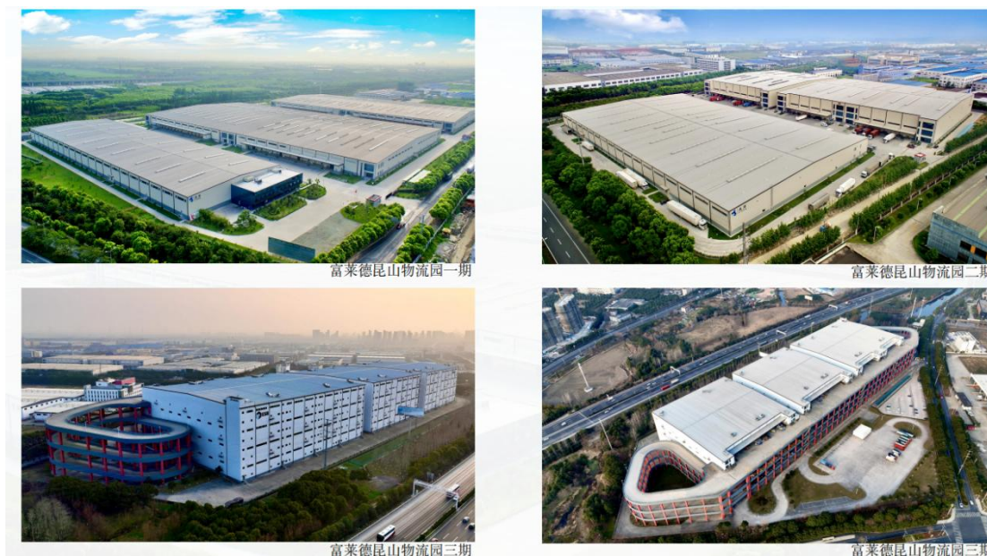
图 14-18 基础设施项目俯瞰图
