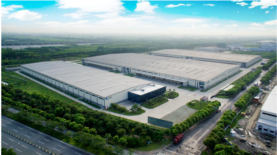
图 14-3 富莱德昆山物流园一期实景图
