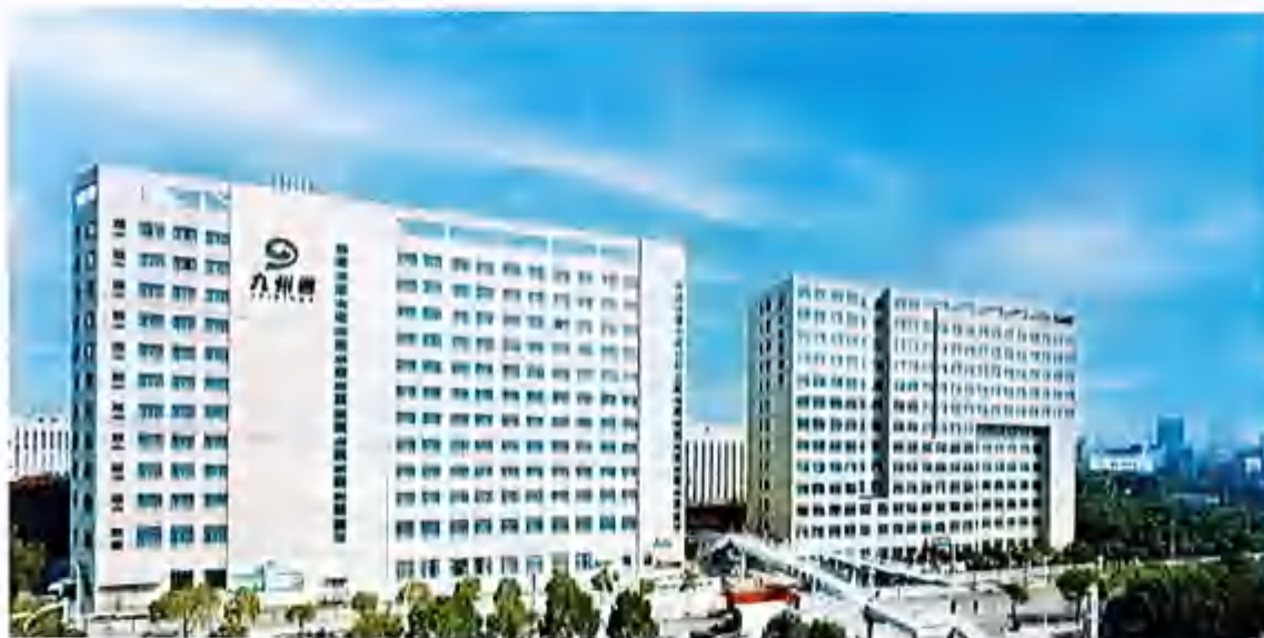
图 2-2 基础设施项目实景图
