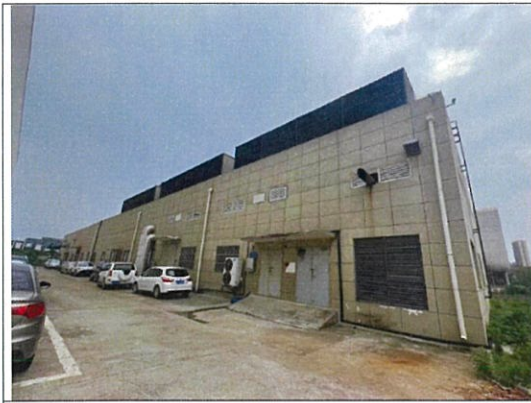
【保障动员中心配套楼】-建筑外观
