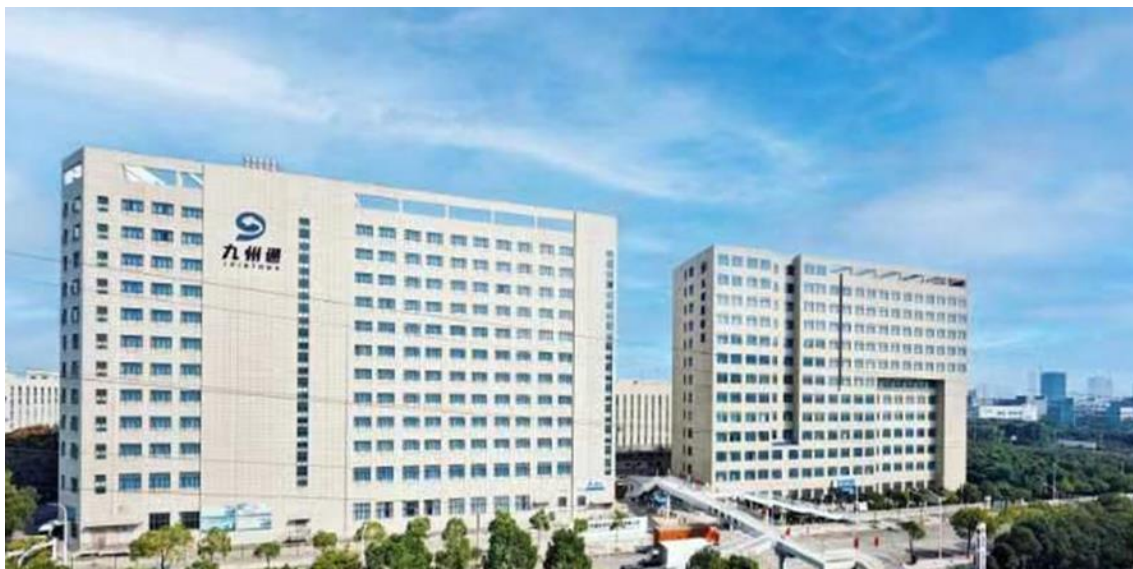
图2-2 基础设施项目实景图
