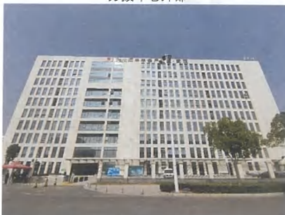
配套办公楼外部
