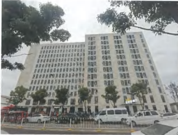
配套综合楼外部
