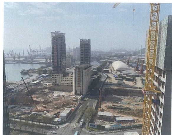
西侧某在建工程
