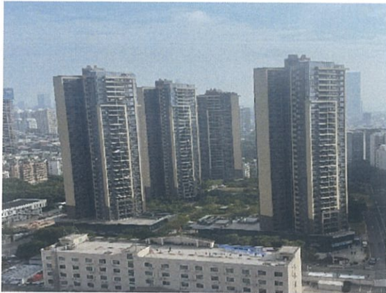
项目二一楼外观
