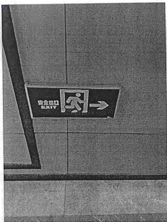
图 3-2-5 设置疏散指示装置功能正常
