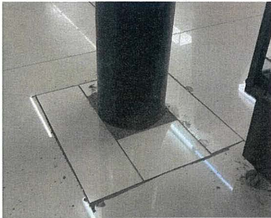
照片 9.3.4 钢柱未锈蚀
