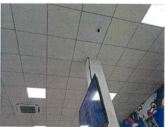
照片 9.3.2 吊顶完好未见变形
