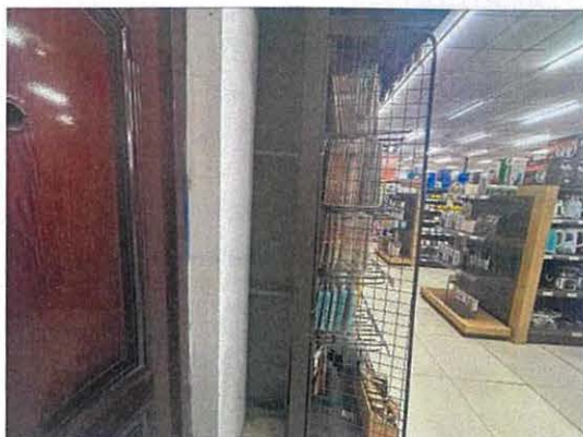
照片 9.3.5 钢柱完后未见锈蚀
