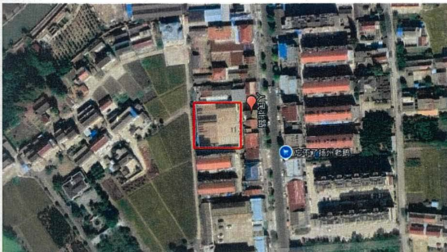
图 4.1 方框内为本次检测位置, 图中向上为正北方向
