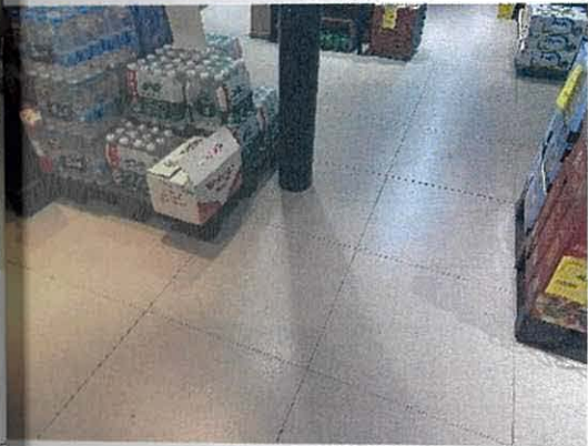
照片 9.3.1 钢柱未锈蚀
