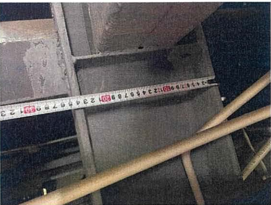
照片 9.1.1 柱截面尺寸测量
