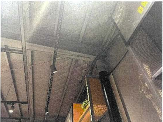
照片 9.3.2 钢柱未锈蚀
