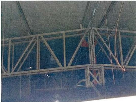
照片 9.3.2 钢桁架基本完好未变形
