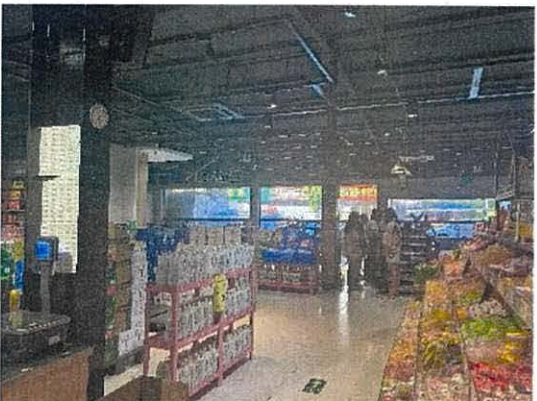
照片 9.3.2 钢柱未锈蚀
