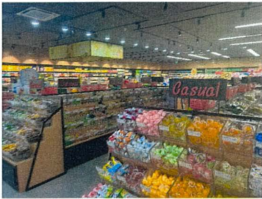
照片 9.3.2 吊顶完好未见变形
