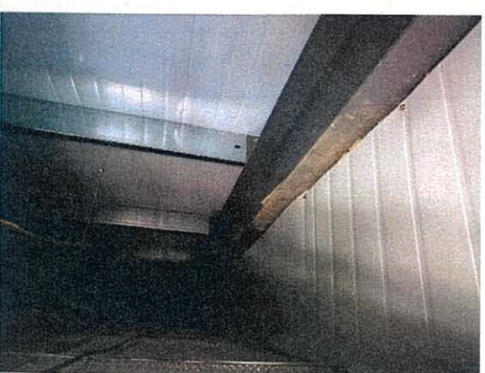
照片 9.3.4 屋面板及墙板完好，为不燃材料夹心彩钢板
