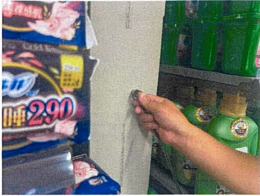
照片 9.2.2 壁厚测量
