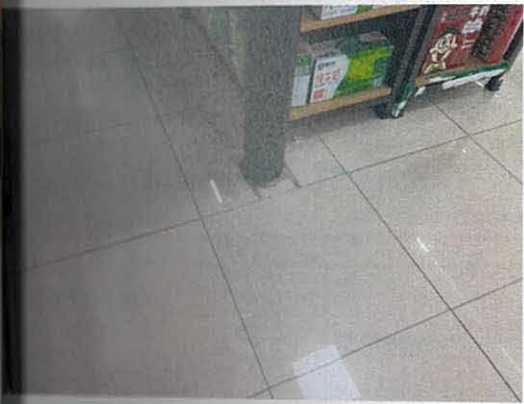
照片 9.3.1 钢柱完好未见锈蚀
