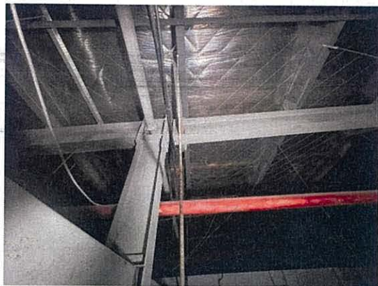
照片 9.3.3 横撑完好，节点牢固
