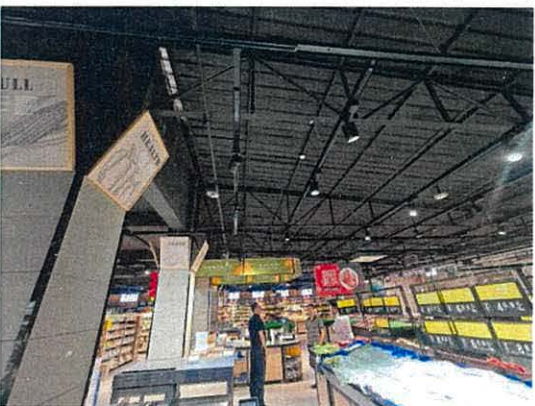
照片 9.3.2 钢屋架未锈蚀
