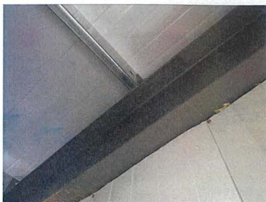
照片 9.3.5 钢梁完好未见锈蚀
