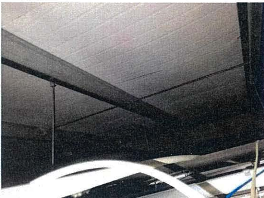
照片 9.3.4 檩条完好未见变形
