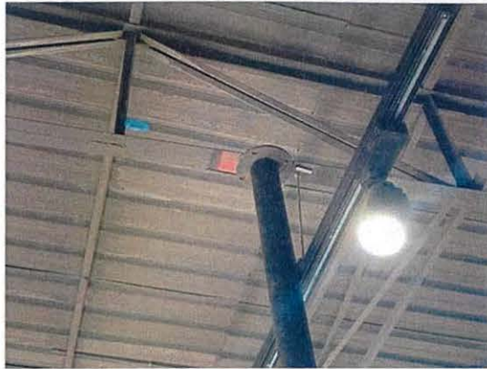
照片 9.3.5 钢柱未锈蚀
