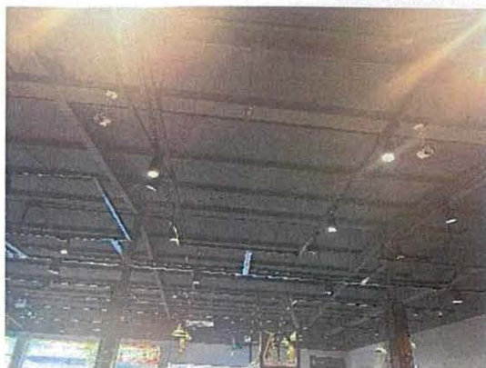
照片 9.3.5 钢梁未锈蚀
