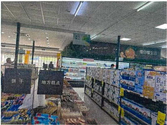
照片 9.3.2 吊顶完好未见变形
