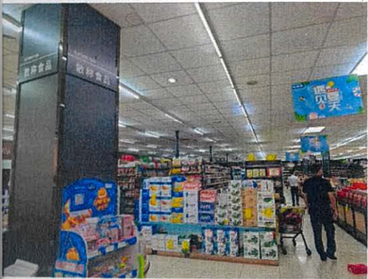
照片 9.3.1 吊顶完好未见变形
