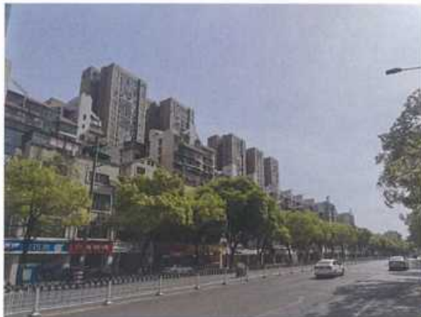
北临新建东路
