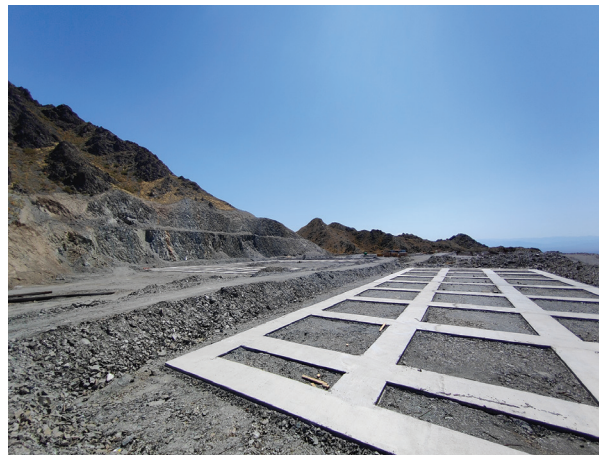
圖8.5：永久住宿營地的土方工程
