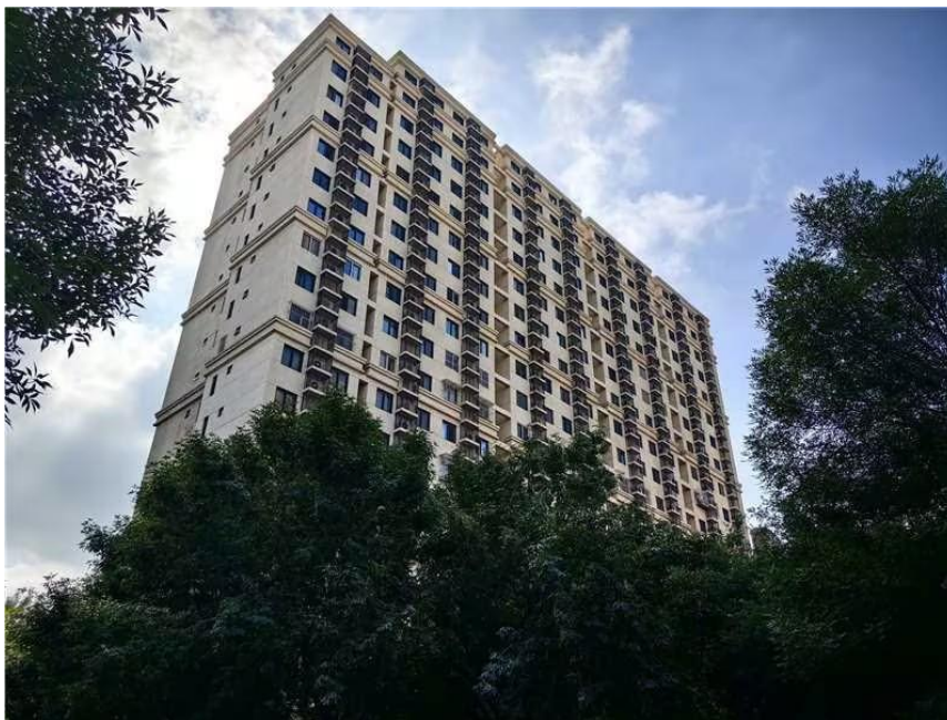
图 14-3 盛悦家园项目实景图
