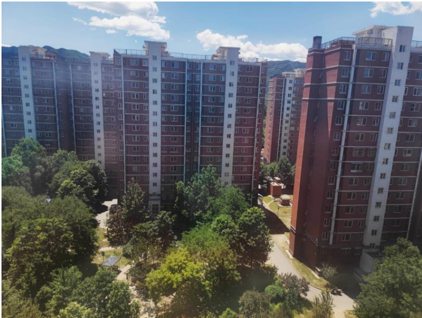
图 14-4 温泉凯盛家园项目实景图
