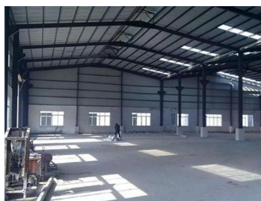
传统工业厂房建筑结构
