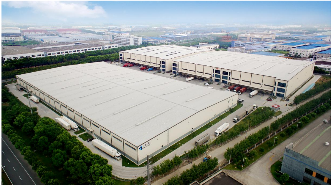
图 14-4 富莱德昆山物流园二期实景图
