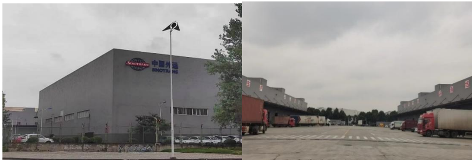
图 2-1-11：成都空港物流项目外景
