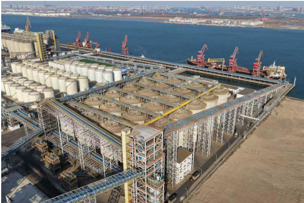
图：筒仓堆存实景图
