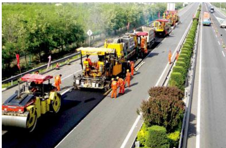
图 30：森远牌就地热再生机组在辽宁大庄公路上施工
