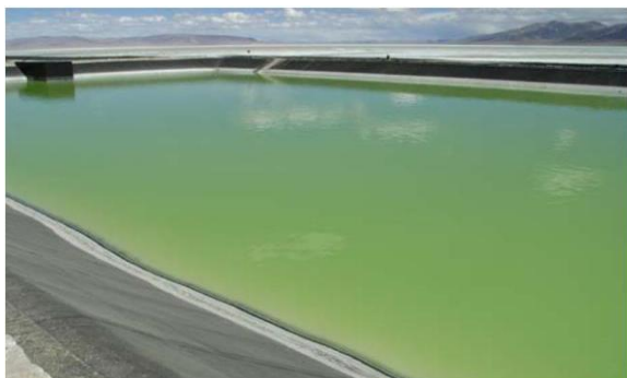
图 9:正在运行中的扎布耶盐湖结晶池
