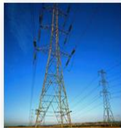
1000kV晋东-南阳-荆门特高压 交流试验示范工程光缆改造线路
