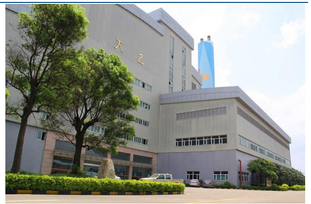
图 8：天乙能源厂区照片
