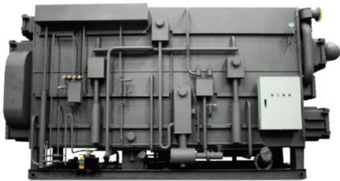
图表 26：烟气余热深度回收机组设备
