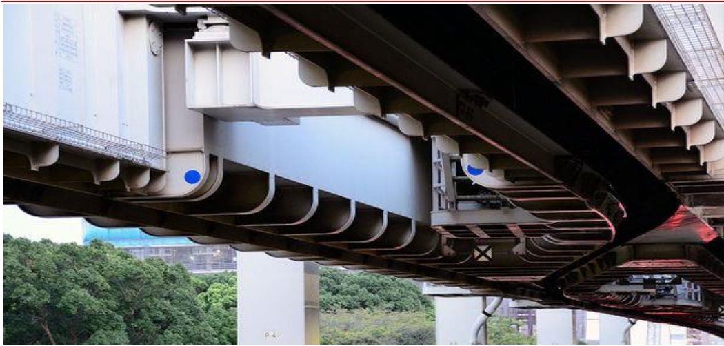
图19： 悬挂式单轨的轨道梁与道岔梁
