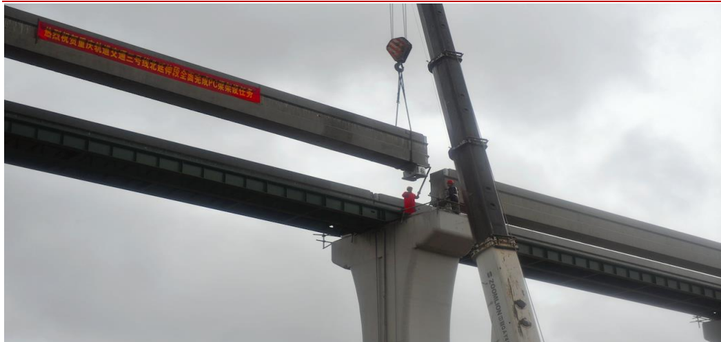
图15： 重庆轨交 3 号线轨道梁铺设过程
