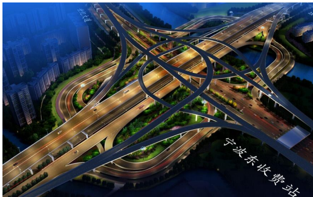
图 16: 新中源工程业绩: 宁波东苑立交快速化改造一期工程 I 标段
