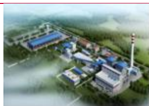
巴基斯坦 Nishat 1×46MW 燃煤电站工程
