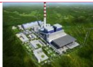
山煤集团低热值煤发电工程 EPC 总承包项目
