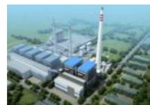
河南晋开集团肥料项目配套 2×480t/h 燃煤锅炉工程建设、供汽项目
