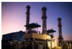
马来西亚沙巴 100MW 联合循环电站项目
