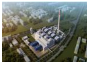
延安煤油气资源综合利用项目热动力站工程
