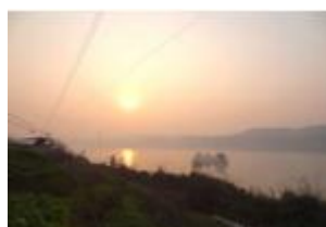
重庆涪陵 220KV 清溪输变电工程项目
