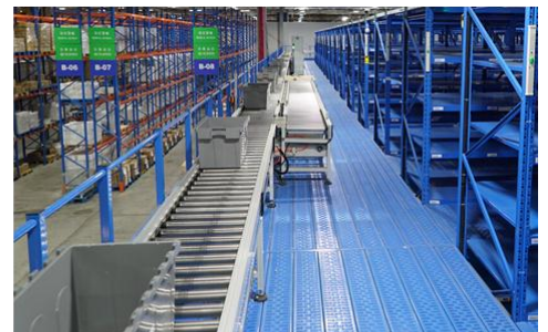
车间输送系统
