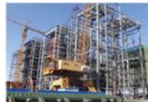
高硫煤洁净利用化电热一体化示范项目一期工程锅炉工段项目
