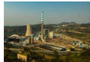
重庆中机龙桥 1×300MW+2×50MW 热电联产项目
