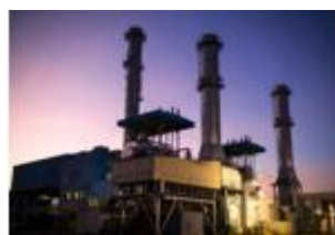
马来西亚沙巴 100MW 联合循环电站项目
