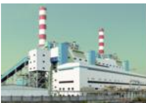
越南广宁热电股份有限公司 4×300MW 电厂项目
