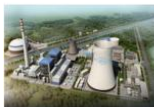
枣庄八一热电公司煤矸石综合利用热电工程 EPC 总承包
