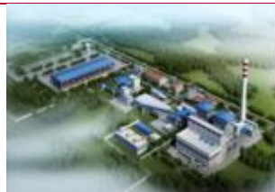
巴基斯坦 Nishat 1×46MW 燃煤电站工程
