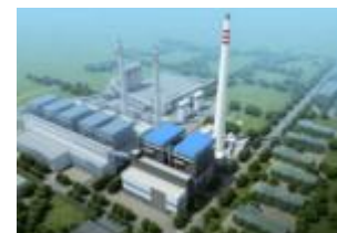
河南晋开集团肥料项目配套 2×480t/h 燃煤锅炉工程建设、供汽项目
