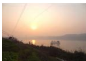
重庆涪陵 220KV 清溪输变电工程项目
