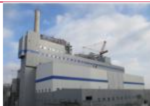
辽宁抚顺热电厂“上大压小”新建项目
