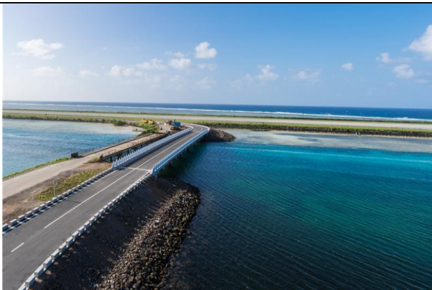
图 22：公司承建的援密克罗尼西亚科斯雷州大桥
