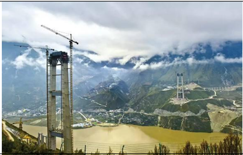
图 1：公司在建雅康高速泸定大渡河特大桥项目——新的入藏大动脉
