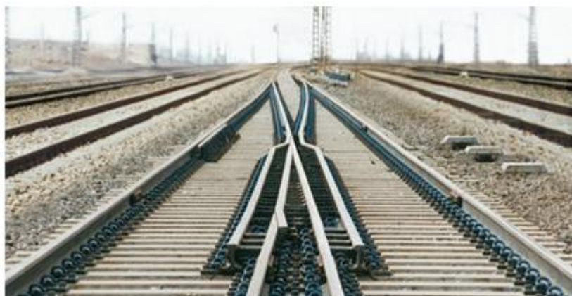
秦沈客运专线 60kg/m 钢轨 38 号提速道岔
