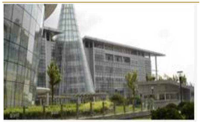
图 10：徐汇数据中心
