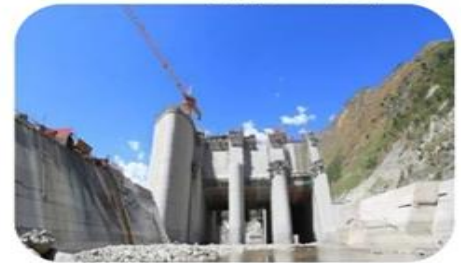
5. 南亚最大水电项目-巴基斯坦 NJ 水电站
