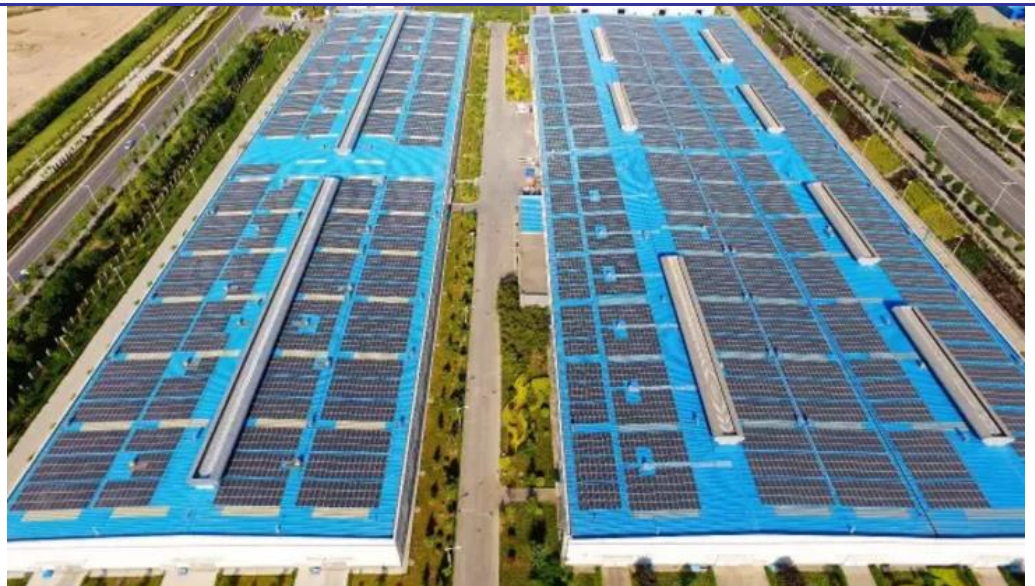
图 11: 西电新能源 5.9MWp 屋顶光伏发电项目
