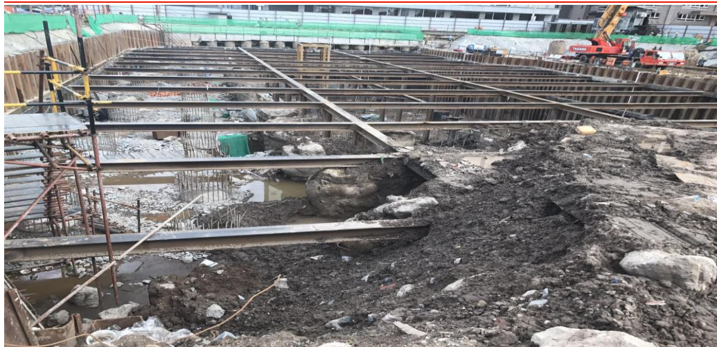
图表10： 香格里拉项目桩基施工现场
