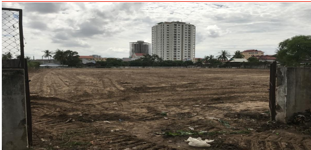
图表15: 紫晶一号项目施工现场
