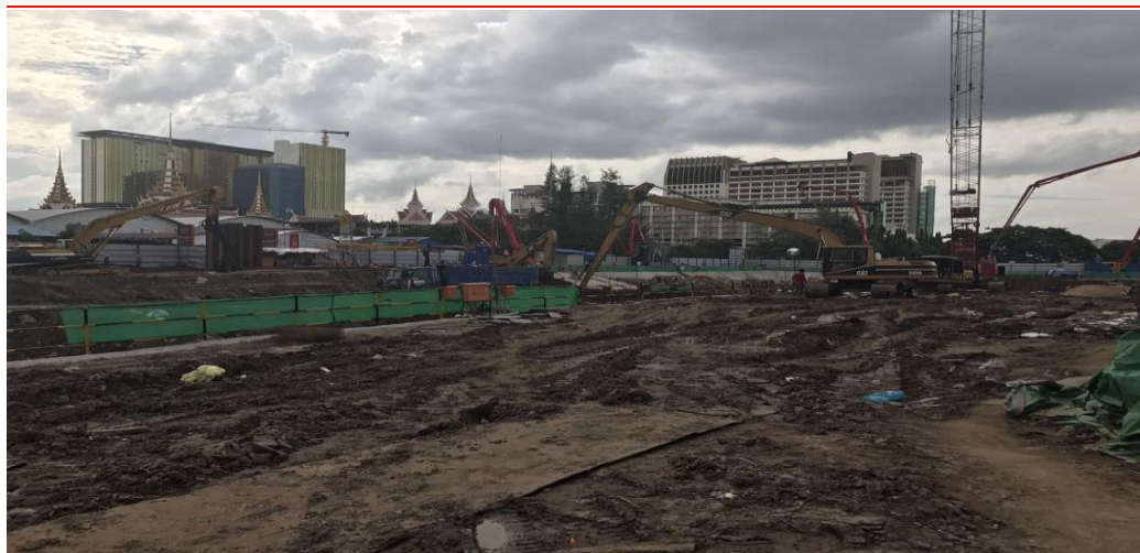
图表11： 香格里拉项目施工现场
