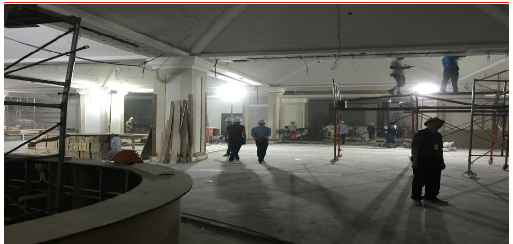
图表6: naga 二期项目施工现场
