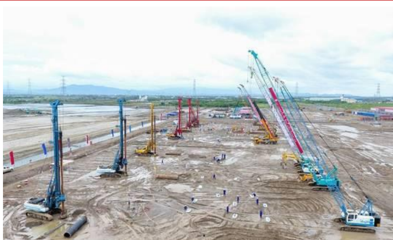
图表 1：印尼迄今为止最大规模火电站爪哇7号2×1050MW燃煤发电项目施工现场
