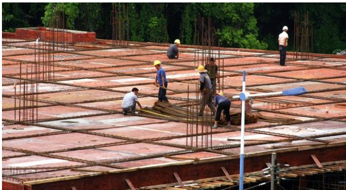
图 20：木制建筑模板
