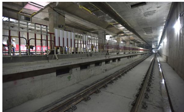
图 24：地铁车站混凝土工程均需使用建筑模板
