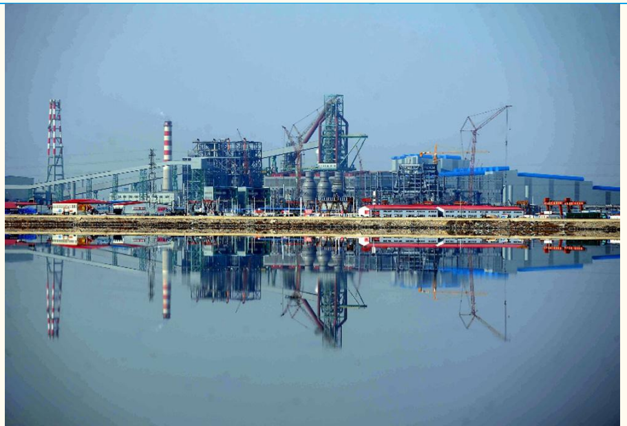
图表 10：京唐二期建设现场
