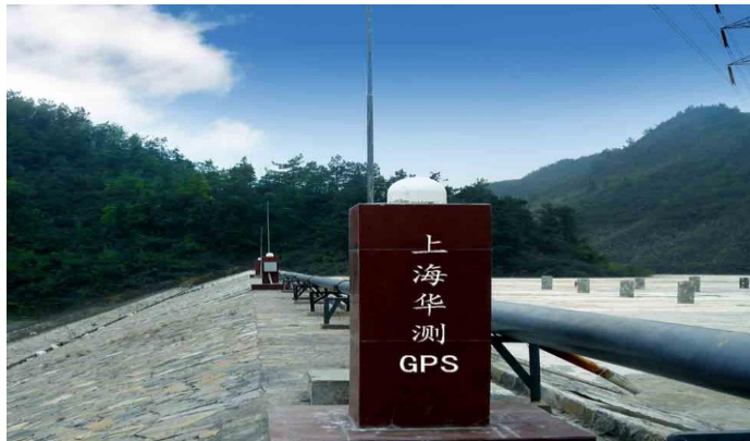
图 20：华测导航北斗 CORS 参考站
