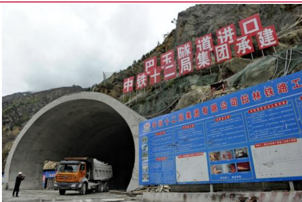
图表 3：川藏铁路拉林段巴玉隧道
