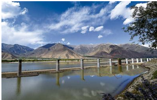
图表 5：拉林铁路段明则特大桥墩台已全部完工
