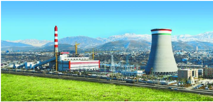
图表31：塔吉克斯坦杜尚别热电厂项目
