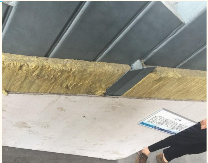
图表 6: 夹层海绵隔音保温
