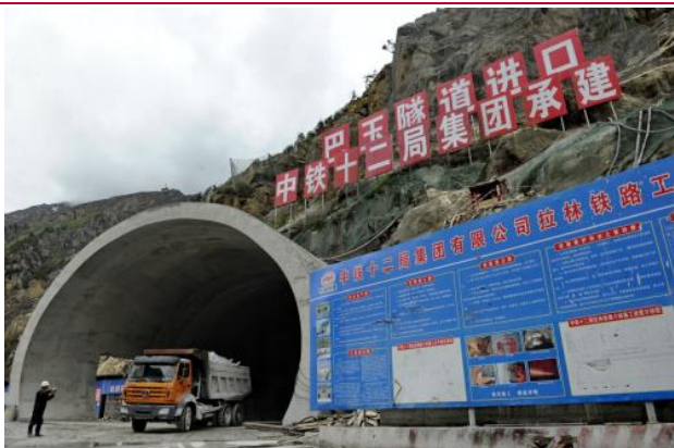
图表 2: 川藏铁路拉林段巴玉隧道
