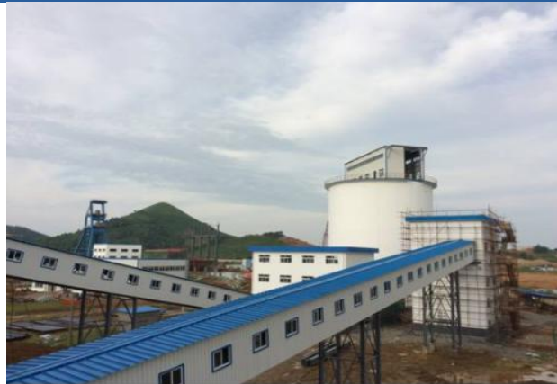
图 23: 沙溪铜矿建设现场图
