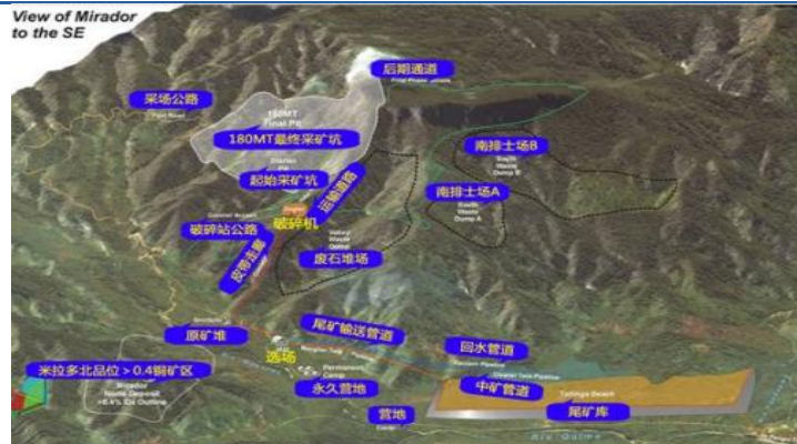
图 24: 厄瓜多尔铜矿建设现场图
