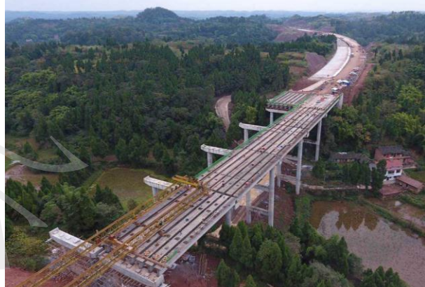
图 2：江习古高速公路 BOT 项目施工现场航拍图
