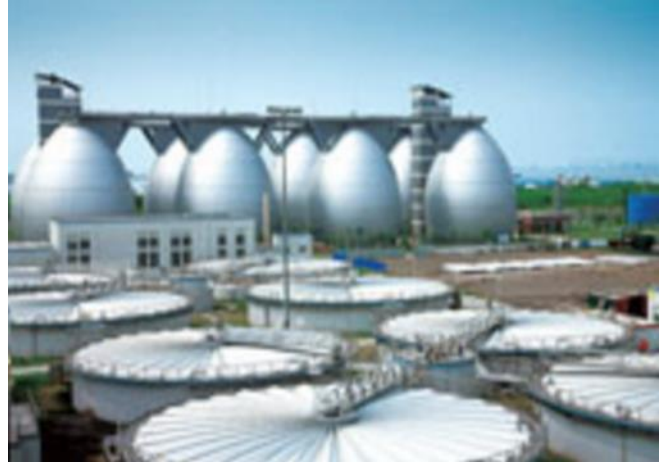
图 13：上海白龙港污水处理厂
