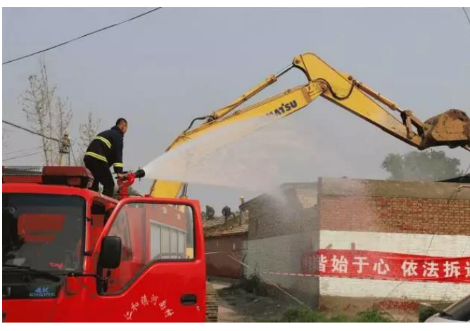
图23: 顺义项目施工现场
